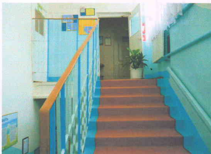
Фото 8. Лестница (внутри здания).
